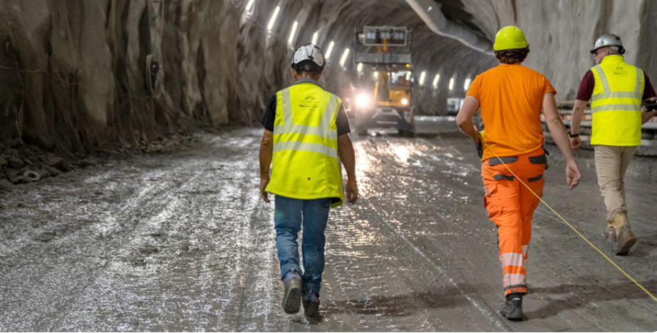
Tunnel in fase di scavo © GIF Photos
