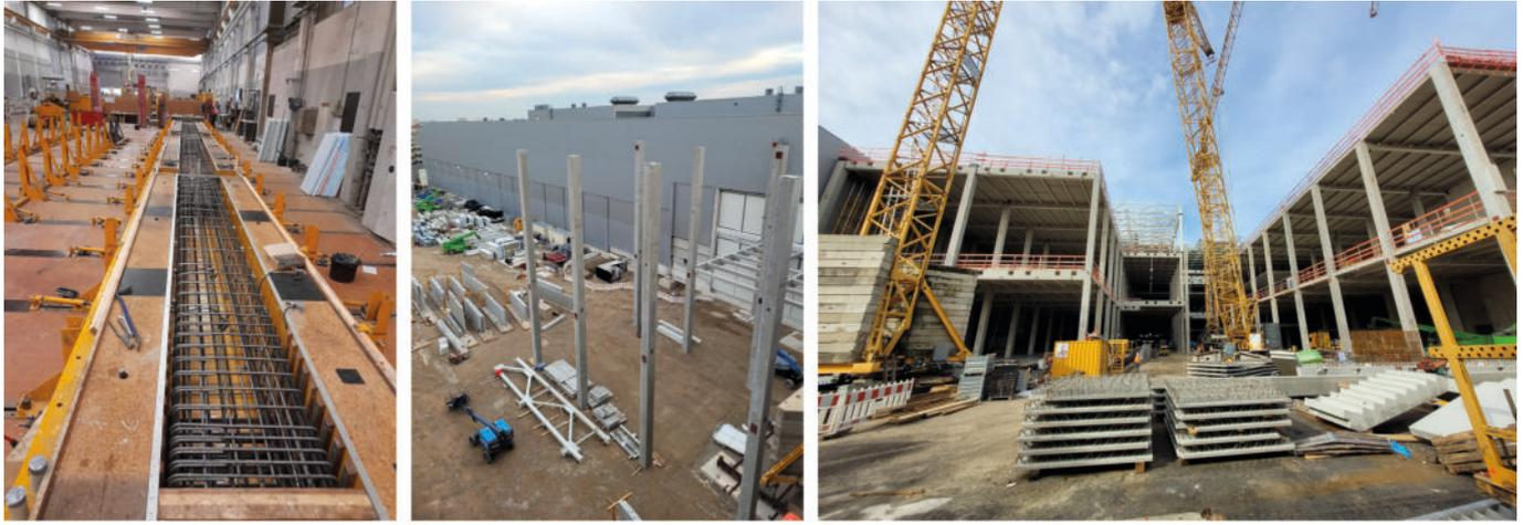
**Bild 5** Vorgespannte Betonstützen in der Schalung (a) und auf der Baustelle (b, c) (Quelle: Max Bögl; Bergmeister Ingenieure)
