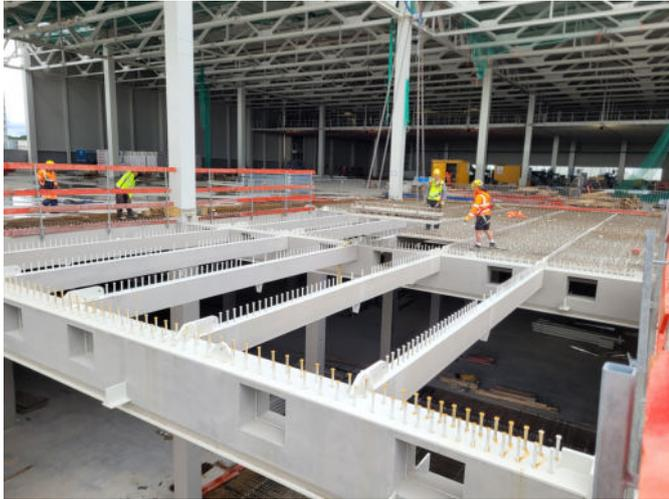
**Bild 7** Verbundhauptträger, Verbundnebenträger und Elementdeckenmontage (Quelle: Bergmeister Ingenieure)
