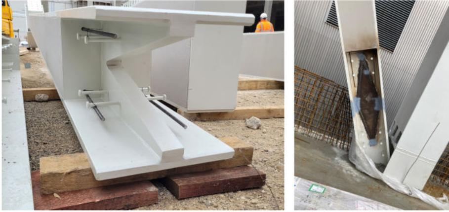
**Bild 12** Diagonalstoß mit eingeschweißtem rautenförmigem Blech S460 als Verbindungsstück am Steg (Quelle: Bergmeister Ingenieure)
