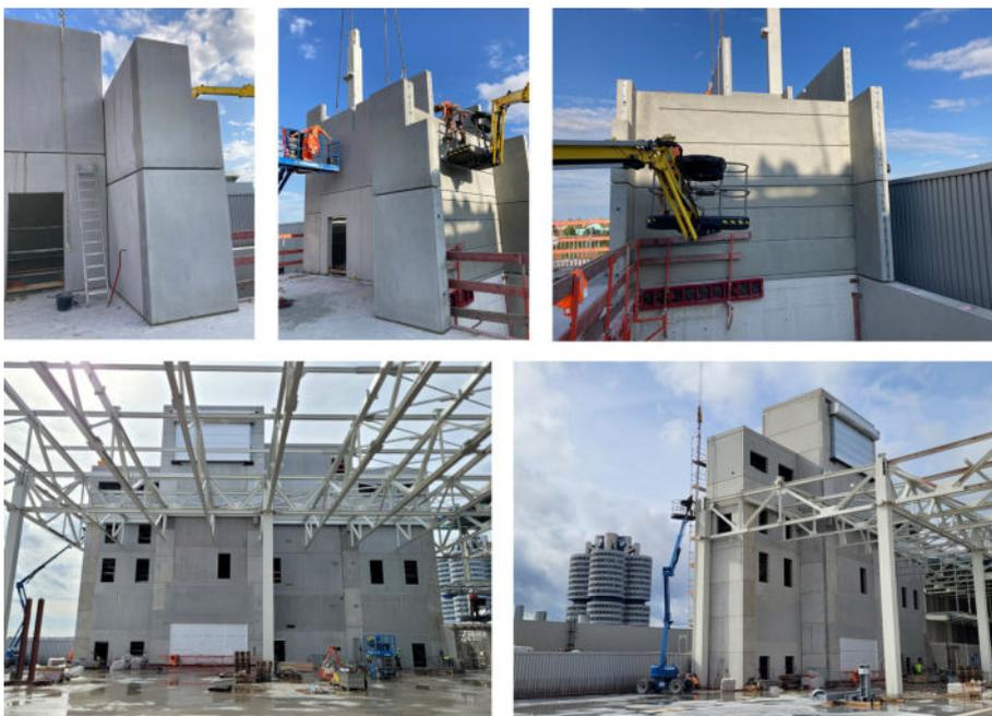
**Bild 4** Baustellenbilder Montage AUS002 im OG 2: Montage einzelner U-Wände bis fertige Montage mit Stahlbau (Quelle: Bergmeister Ingenieure)
